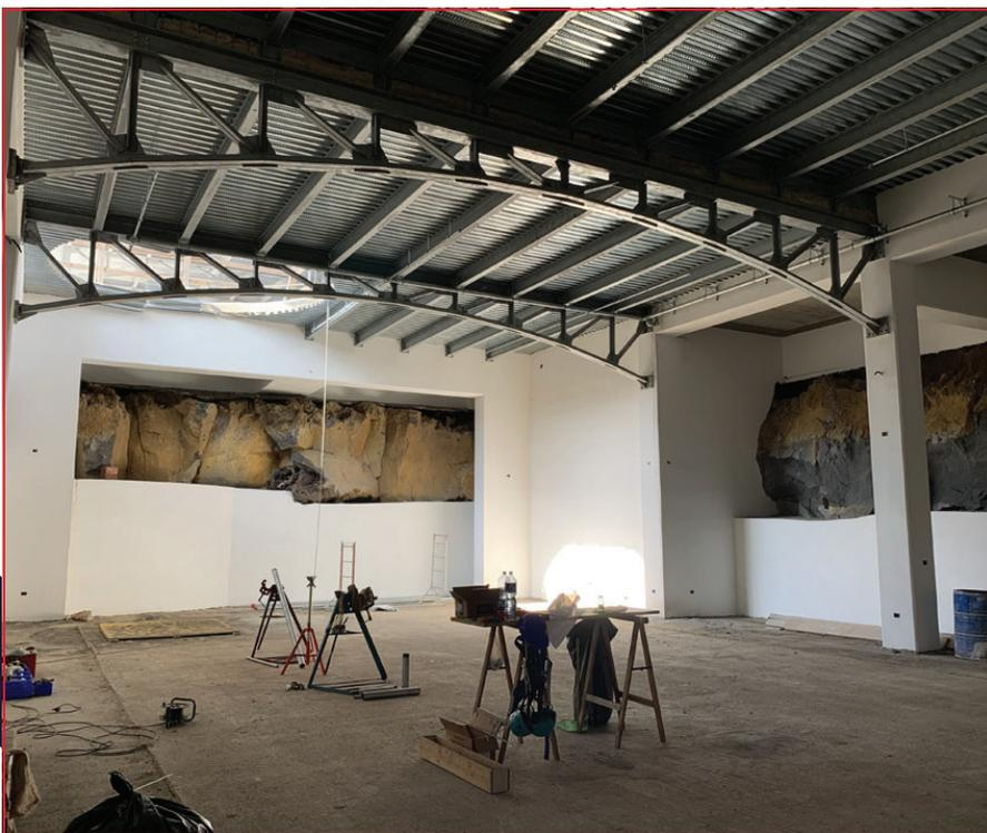
/ Figura 16 / Piano interrato con particolare della reticolare e le connessione acciaio - c.a.
