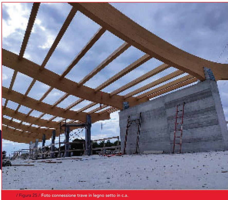
/ Figura 25 / Foto connessione trave in legno setto in c.a.
