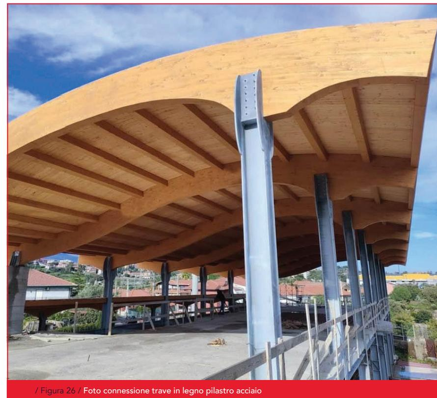
/ Figura 26 / Foto connessione trave in legno pilastro acciaio
