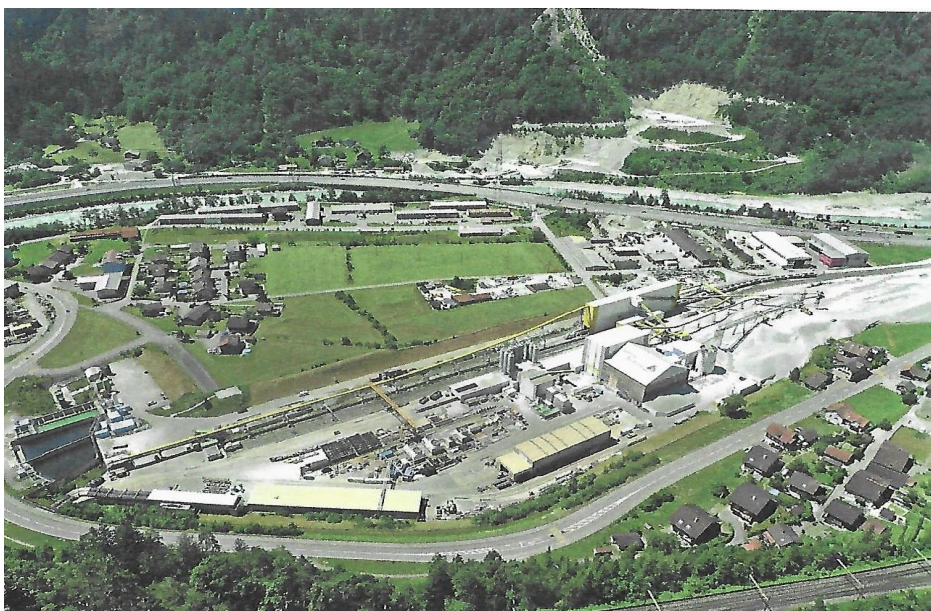
Foto: un cantiere del Gran San Gottardo
