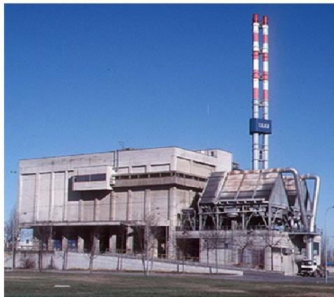
Gli inceneritori con recupero energetico sono impianti utilizzati per lo smaltimento dei rifiuti mediante un processo di combustione ad alta temperatura.
