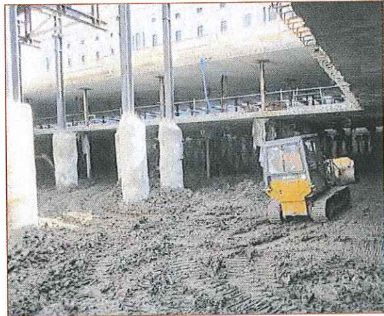
m) 2011.02.17 Vista dei pali in c.a di ammortamento dei montanti in acciaio
