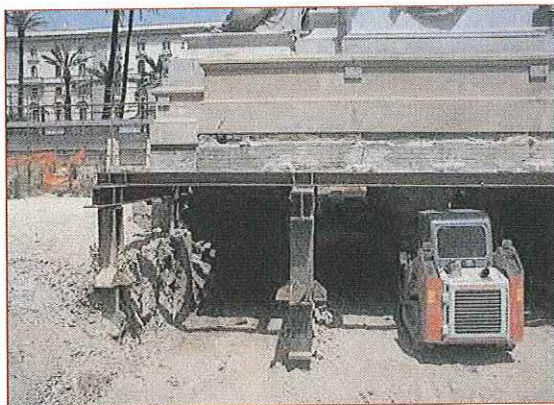
f) 2007.06.22 Demolizione primo muro interno
