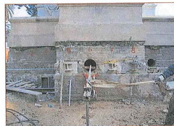
c) 2007.03.05 Realizzazione fori nel basamento ed inserimento travi HEM 240
