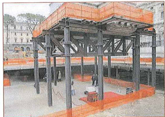
h) 2010.10.18 Getto di magrone a livello del secondo interrato per allestimento visita delle autorità
