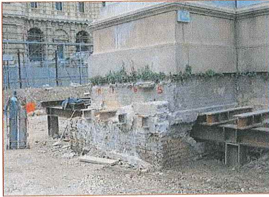
d) 2007.04.03 Realizzazione dell'impalcato di sostegno del monumento
