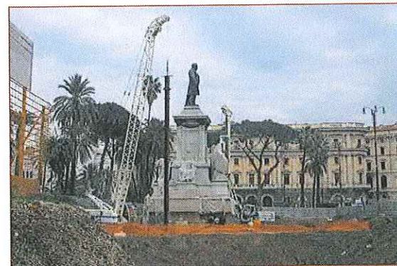
b) 2006.12.14 Realizzazione pali-pilastro provvisori - Calo delle putrelle nei fori con annessamento nel cls fresco
