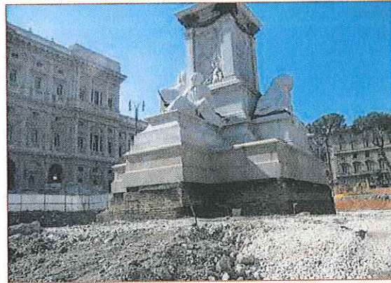
a) 2005.09.22 Messa a nudo delle strutture di fondazione
