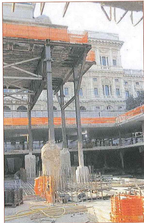
n) 2011.03.30 Realizzazione della fondazione al di sotto del monumento
