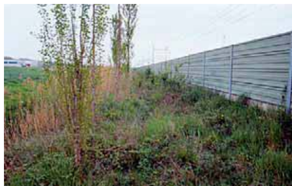
Fascia boscata tampono di corredo a barriera fonoassorbente, dopo 1 anno Scalo ferroviario di Cervignano (UD) Foto G. Sauli - 1986
