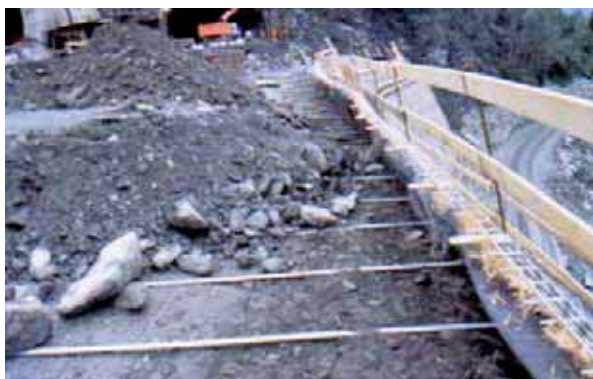
Terra rinforzata verde in fase di costruzione. Svincolo di Morgex Autostrada Aosta-Monte Bianco Foto G. Sauli
