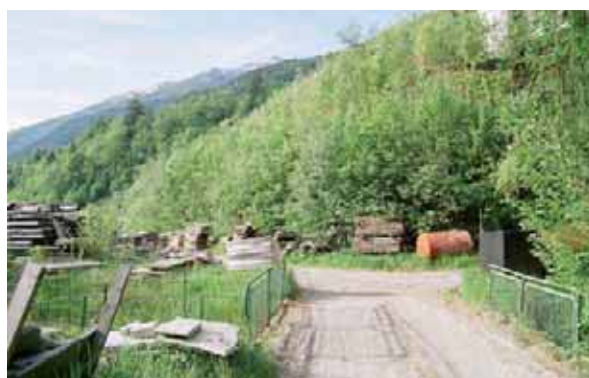
Terra rinforzata con messa a dimora di talee di salice, Svincolo di Morgex, dopo alcuni anni Foto G. Sauli
