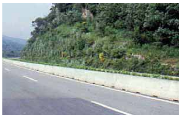
Muro verde in terra armata rinverdito Autostrada dei Trafori Loc. Inverio Foto G. Sauli - 1998
