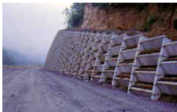
Muro verde in terra armata in opera Autostrada dei Trafori Loc. Inverio Foto G. Sauli - 1990
