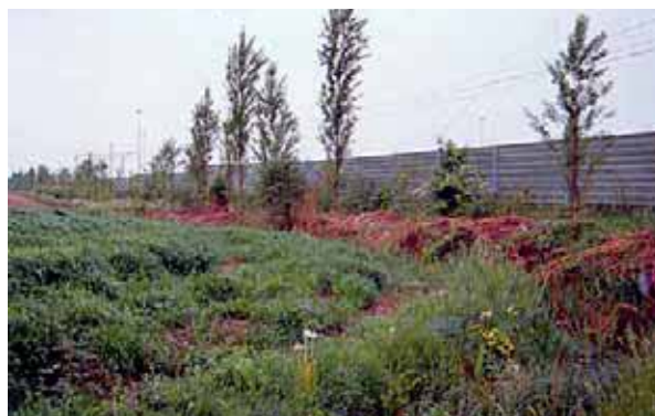
Formazione fascia boscata tampono di corredo a barriera fonoassorbente. Scalo ferroviario di Cervignano (UD) Foto G. Sauli - 1985
