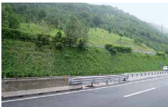
Terra rinforzata rinverdita, a 15 anni dall'intervento. Pian di Vedoia Autostrada Vittorio Veneto, 2008 Foto G. Sauli
