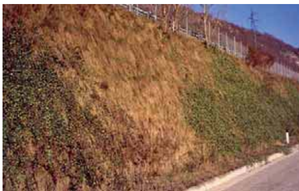
Terra rinforzata rinverdita, a 10 anni dall'intervento. Pian di Vedoia Autostrada Vittorio Veneto, 2003 Foto G. Sauli
