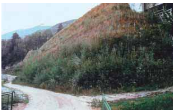
Terra rinforzata con messa a dimora di talee di salice, Svincolo di Morgex Foto G. Sauli
